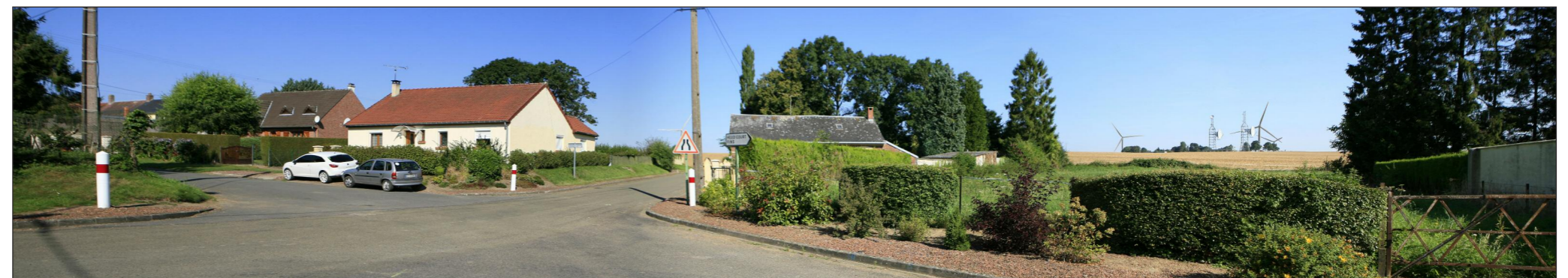
Vue du site avant projet
