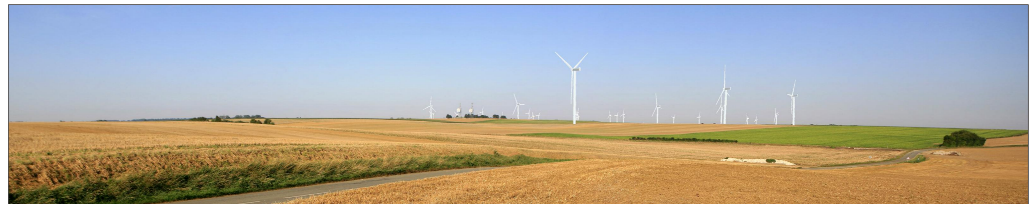
Vue du site avant projet
