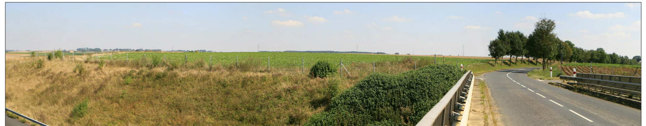
Vue du site avant projet
